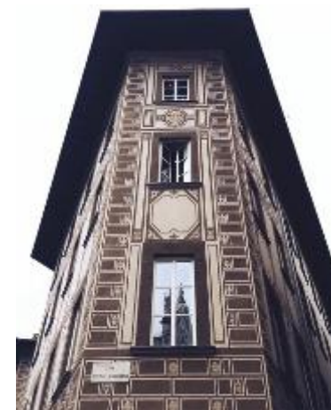
Particolare di un condominio in Piazza S. Croce
